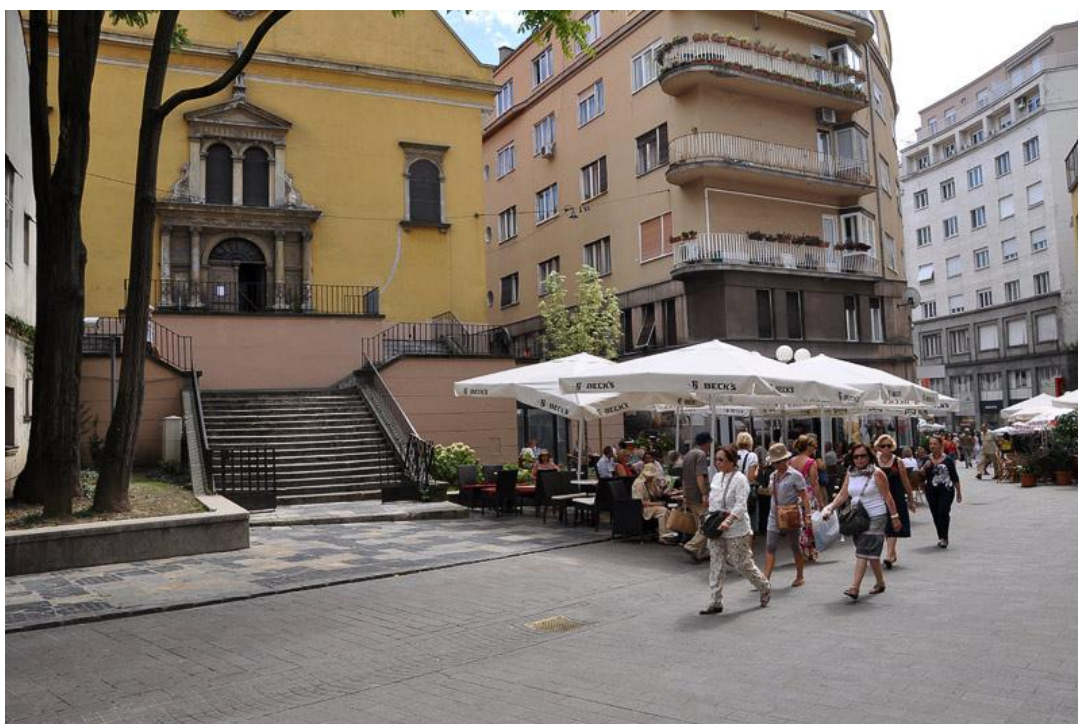
2011. Zapadno pročelje crkve Sv. Marije
