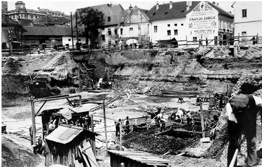
1928. Gradilište buduće tržnice Dolac
